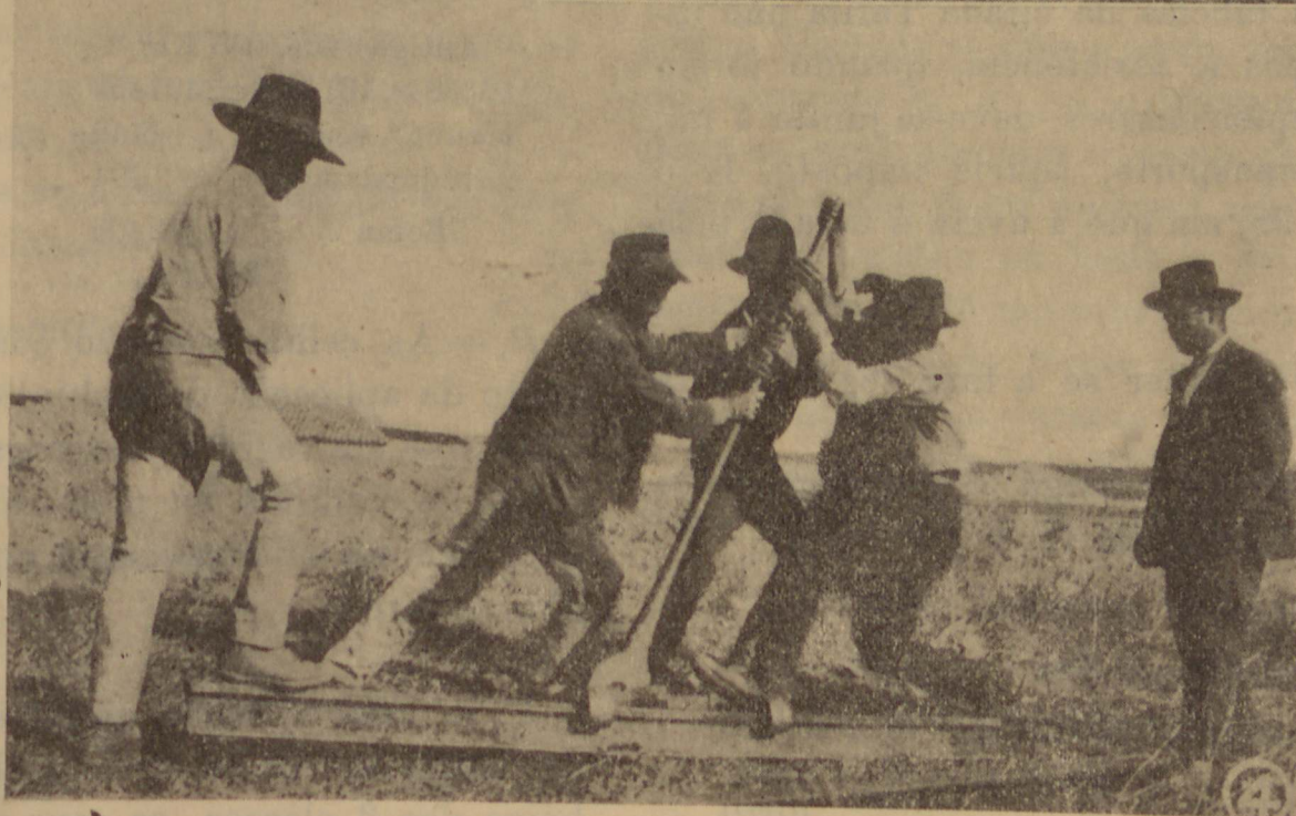
(4) — Ao endireitar um carril, fotog. do Sr. Dr. A. Galvão, Chefe de Secção Adjunto da Via e Obras.
