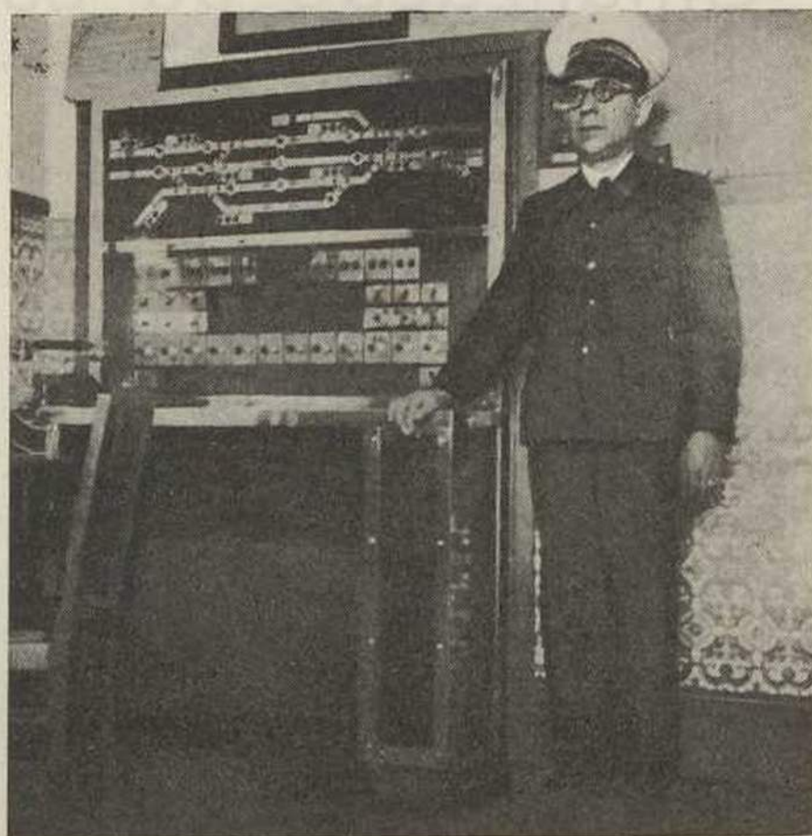
O Chefe da estação junto do aparelho central do comando e quadro de vias
