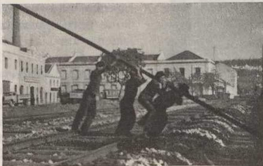
Arvorando um poste de carril com 240 Kg. sem auxílio de qualquer engenho.
