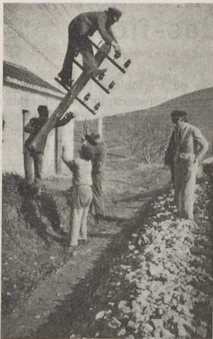
Partiu-se um postelete! É necessário desligar-lhe as linhas para o retirar.
