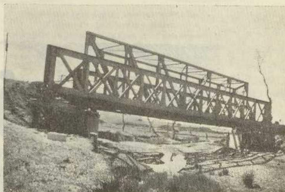
Vista da linha de água com a ponte velha já sobre cavaletes e a parte nova do lado oposto
