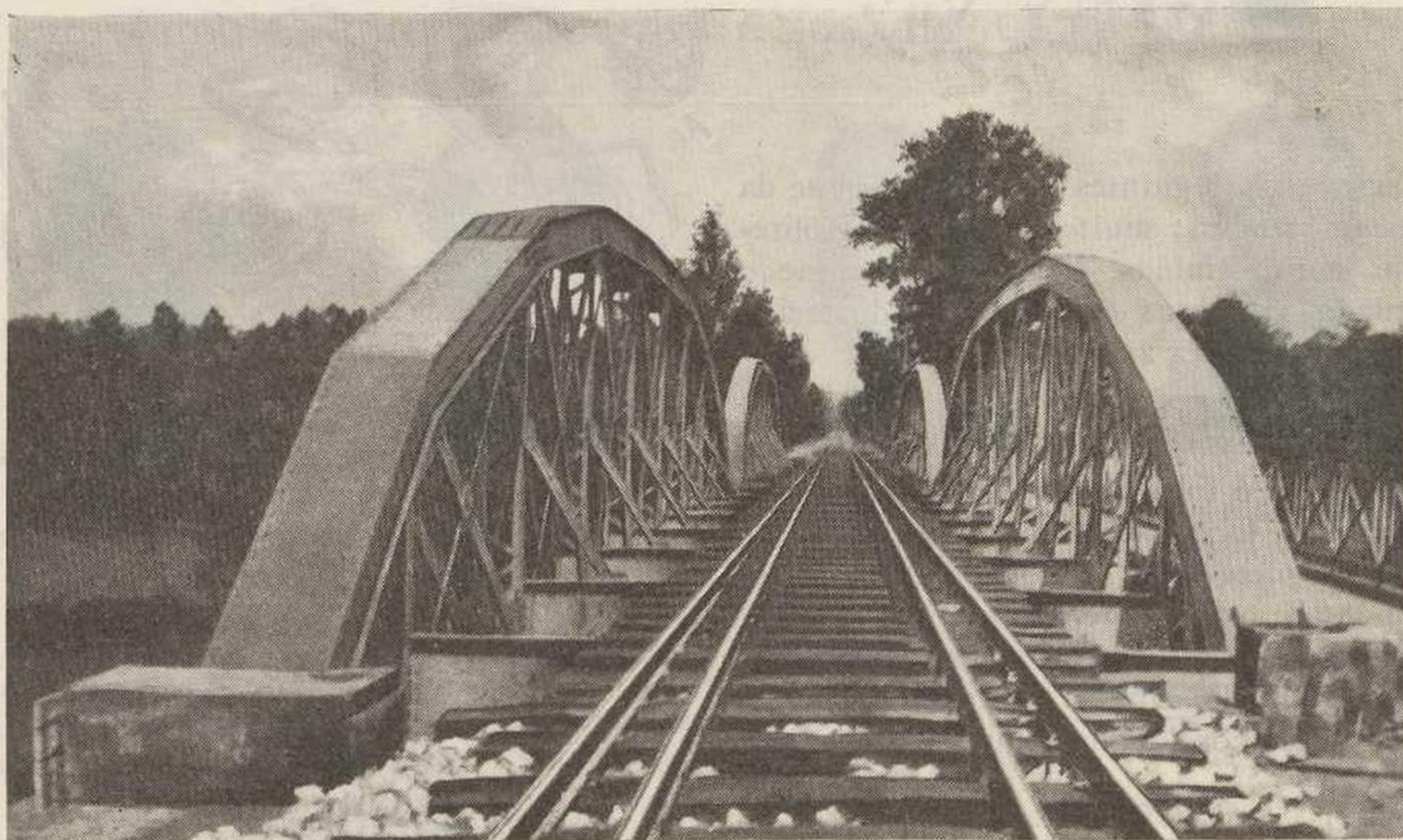
Linha do Douro — Trofa — Ponte sobre o Rio Ave
