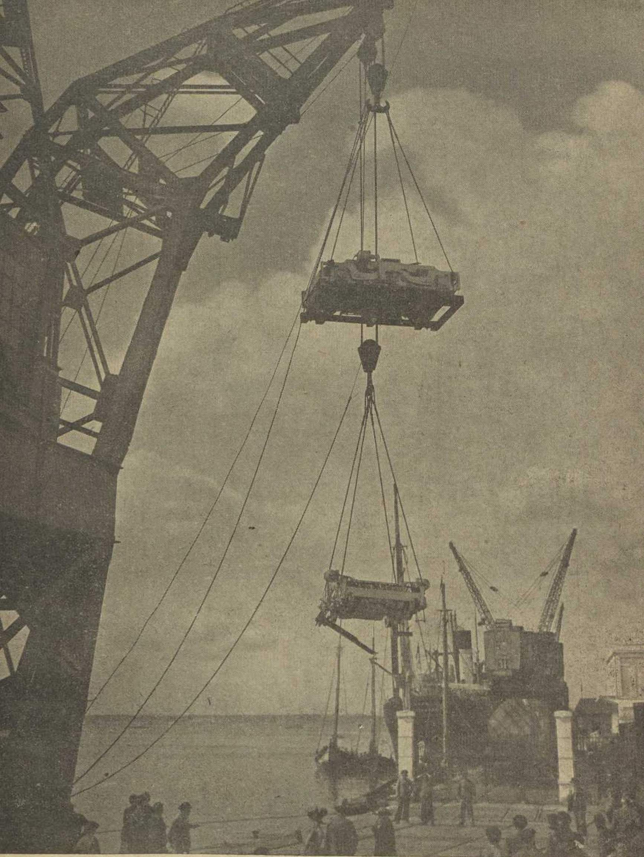
A cábrea «António Augusto de Aguiar» descarregando as «Boggies» das novas locomotivas «Diesel-Eléctricas»
