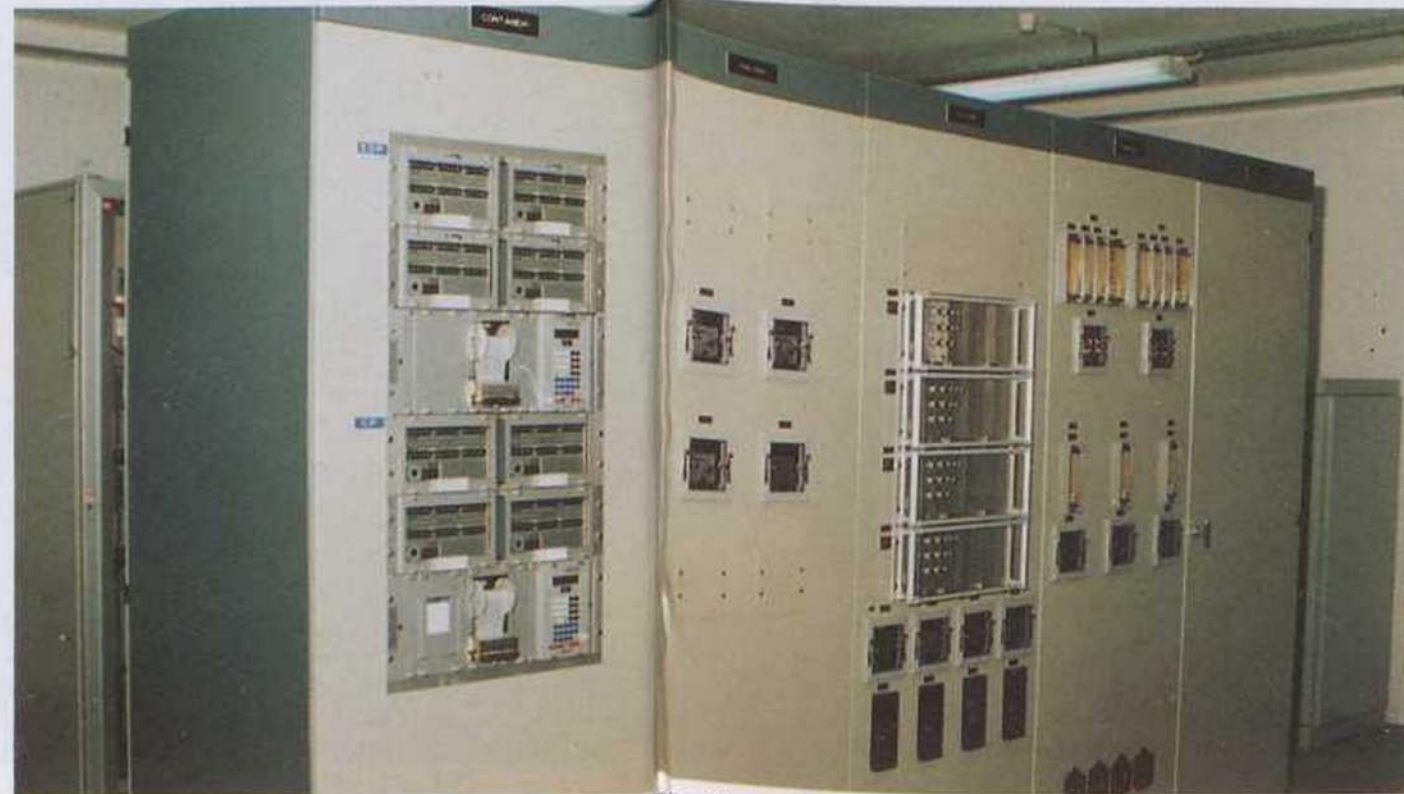
Armário de contagens, com equipamento de alta precisão. Com ele obtém-se a indicação local e a telecontagem da energia consumida (Foto: Viriato)
