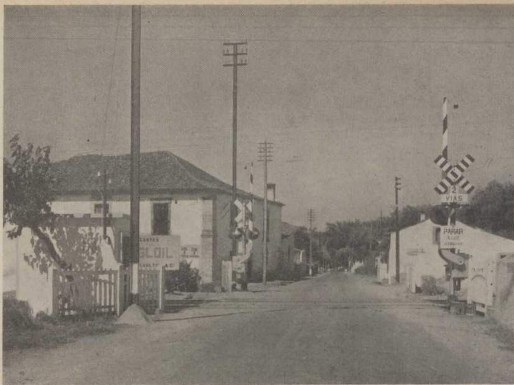
A passagem de nível da Adémia na linha do Norte, que acaba de ser dotada com instalação eléctrica de sinalização luminosa e comando automático de meias-cancelas basculantes
