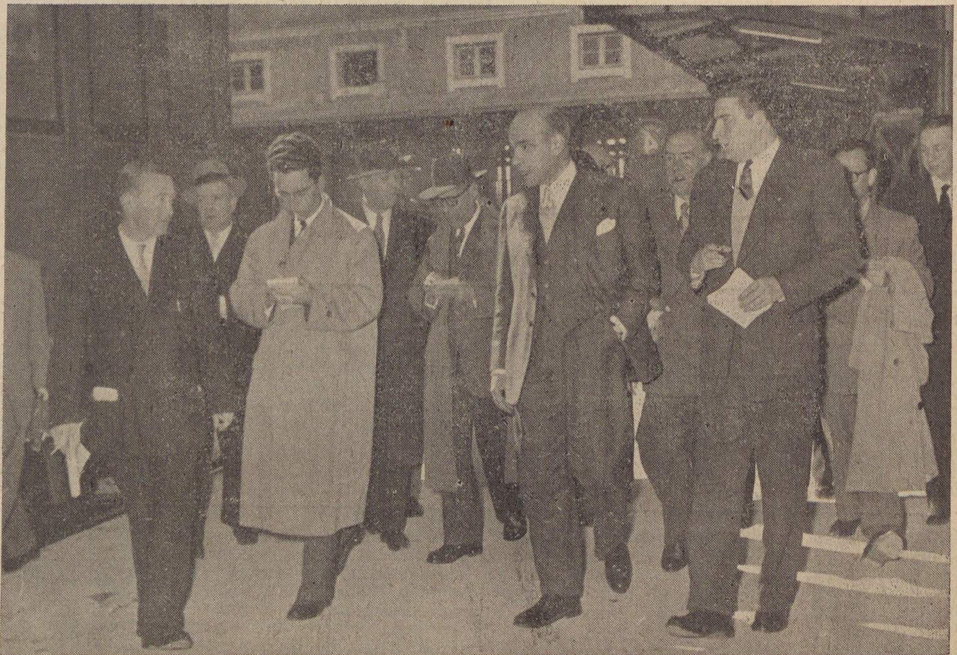
O Engenheiro Espregueira Mendes, Director Geral da C. P., acompanha os jornalistas numa rápida visita às obras em curso em Santa Apolónia, para onde se desviaram os comboios rápidos e correios do Norte e linhas afluentes, devido aos trabalhos preliminares da electrificação das linhas de Sintra e Entroncamento
