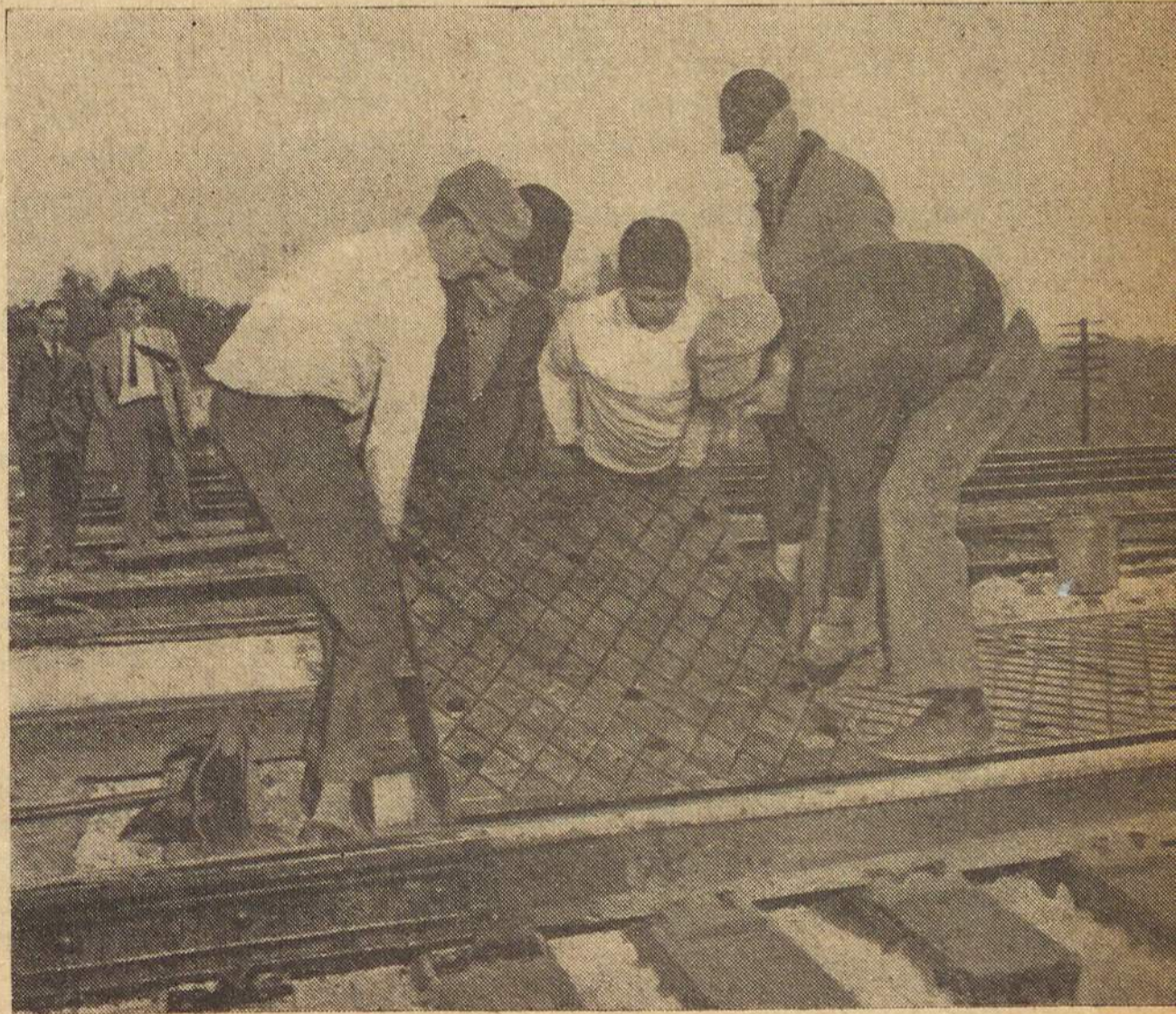
A colocação das placas que serão fixadas por cavilhas
