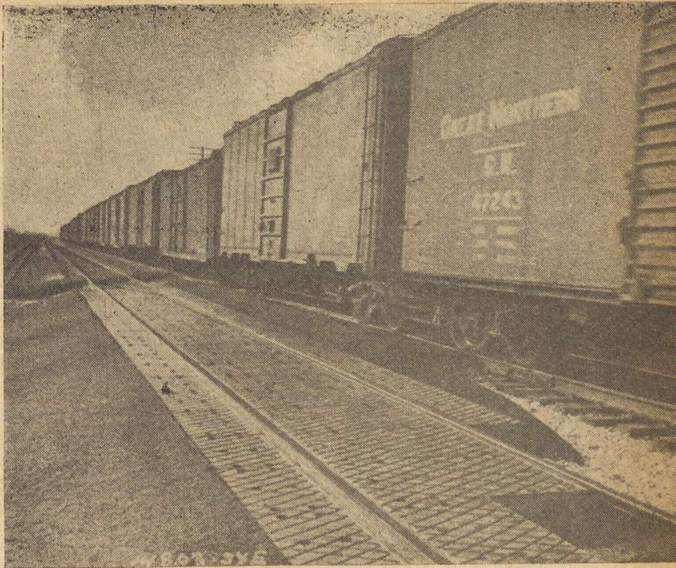
Aspecto da passagem de nível com pavimentos de borracha
