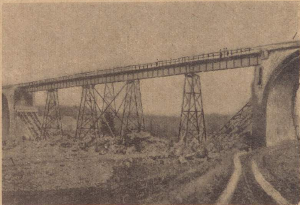
O viaducto de Origny de 22 metros de altura e 216 metros de comprimento, destruída durante a Grande Guerra foi reparada em 46 dias por 140 homens
