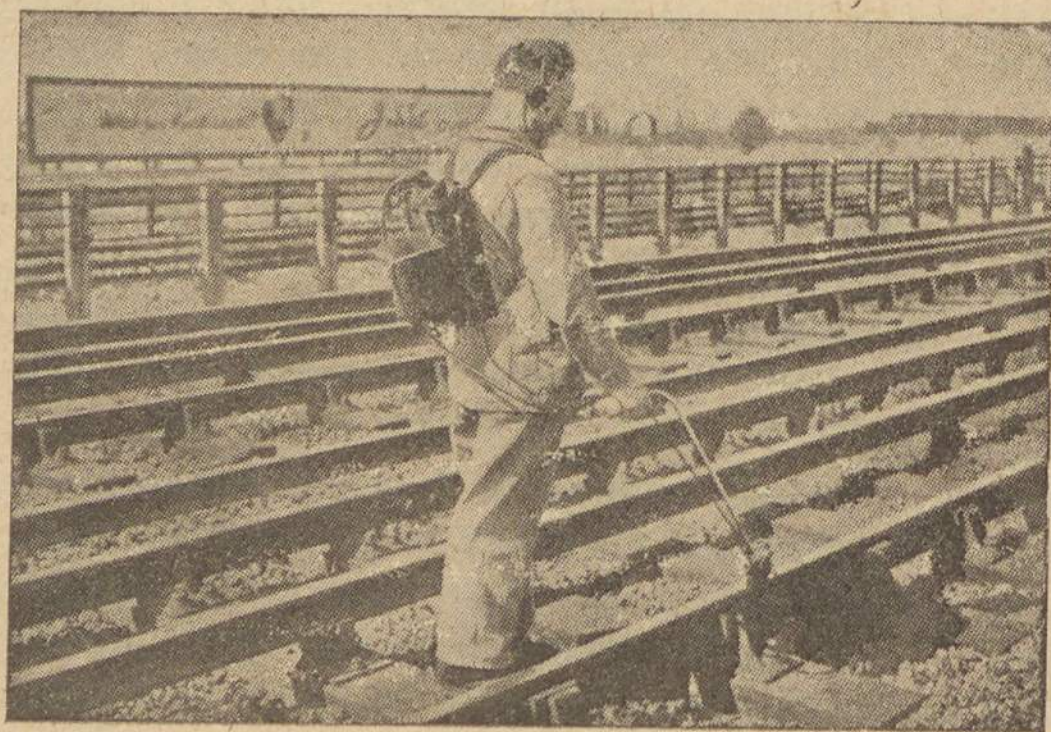
Um recente aparelho que denuncia as falhas dos carris, já utilizado entre nós
