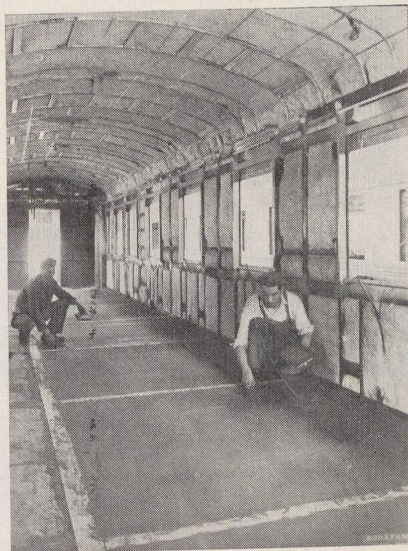
Fig. 9 — Isolamento interior da caixa e preparação do chão
