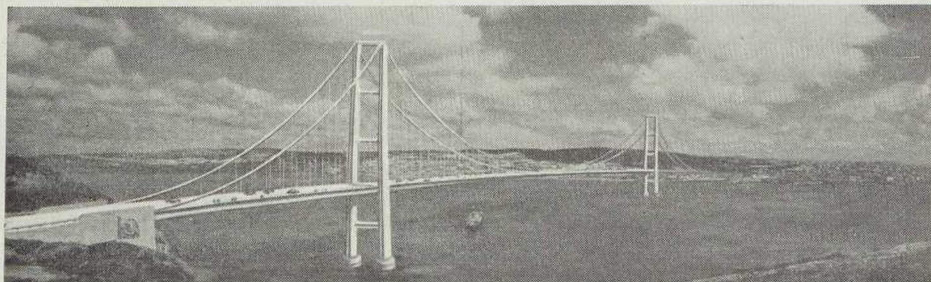
A nova ponte, vista da margem sul, junto ao Monumento a Cristo-Rei. Com 15 m. de largura da faixa de rodagem rodoviária, além dos passeios, a ponte terá 80 m. de altura sobre o rio e unicamente 2 pilares. O vão central mínimo é de 1000 m. e o vão lateral 350 m.. Prevê-se via dupla ferroviária electrificada.
