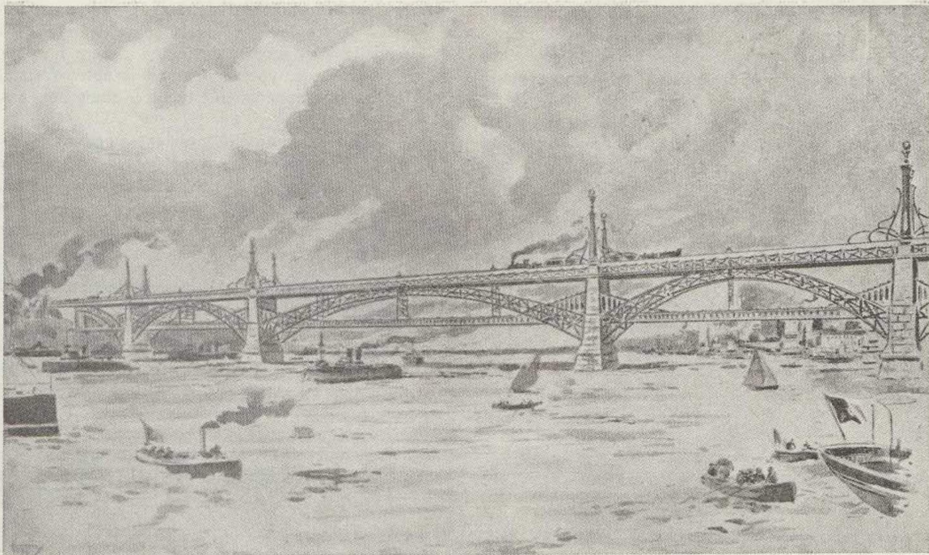
Visão da ponte metálica Miguel Pais, primeira tentativa concreta de ligação contínua entre Lisboa e a Outra Banda, estudada em 1876. Possuiria 4 300 m. de extensão e localizava-se entre Montijo e Xabregas. Destinava-se simultaneamente ao trânsito ferroviário e rodoviário
