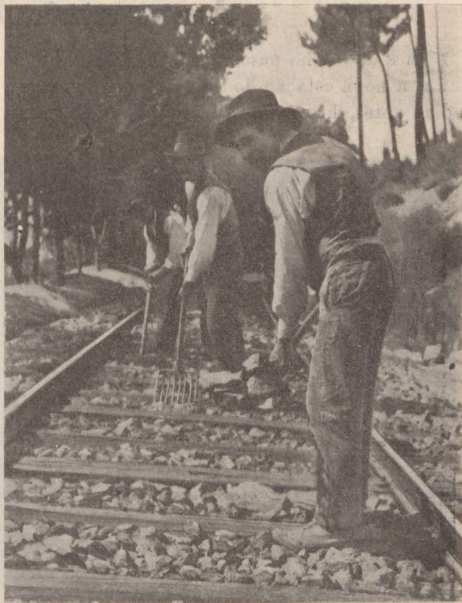
Depuração do balastro por meio de forquilhas
