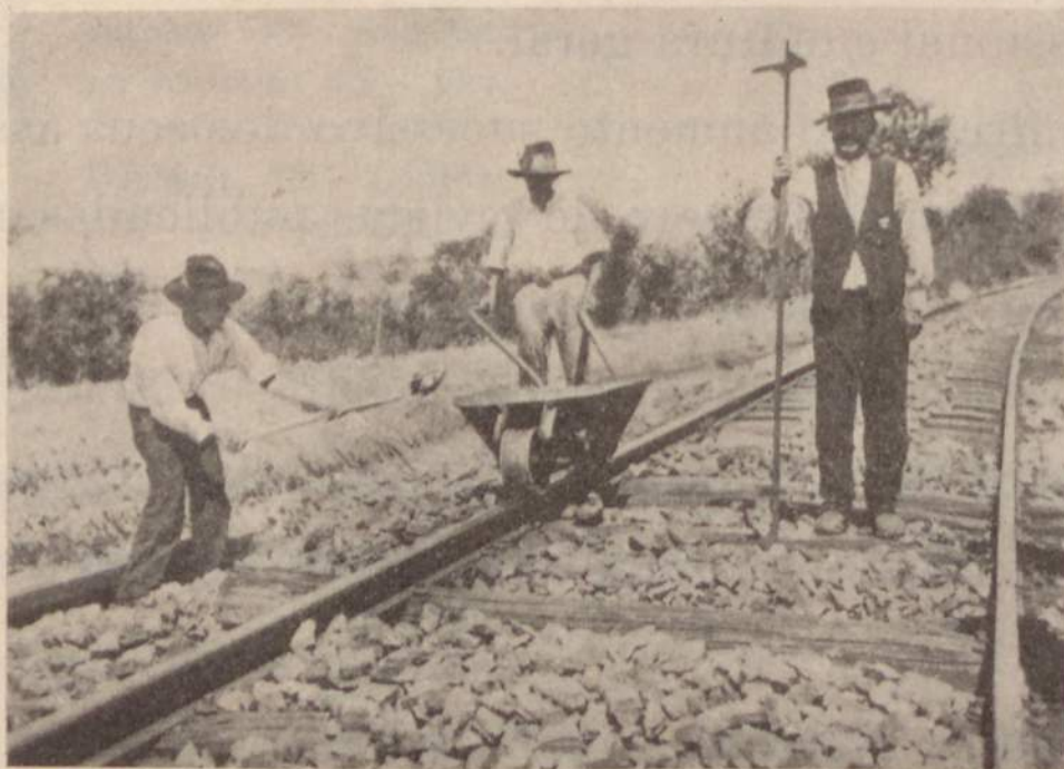
Transporte de materiais em carro americano
