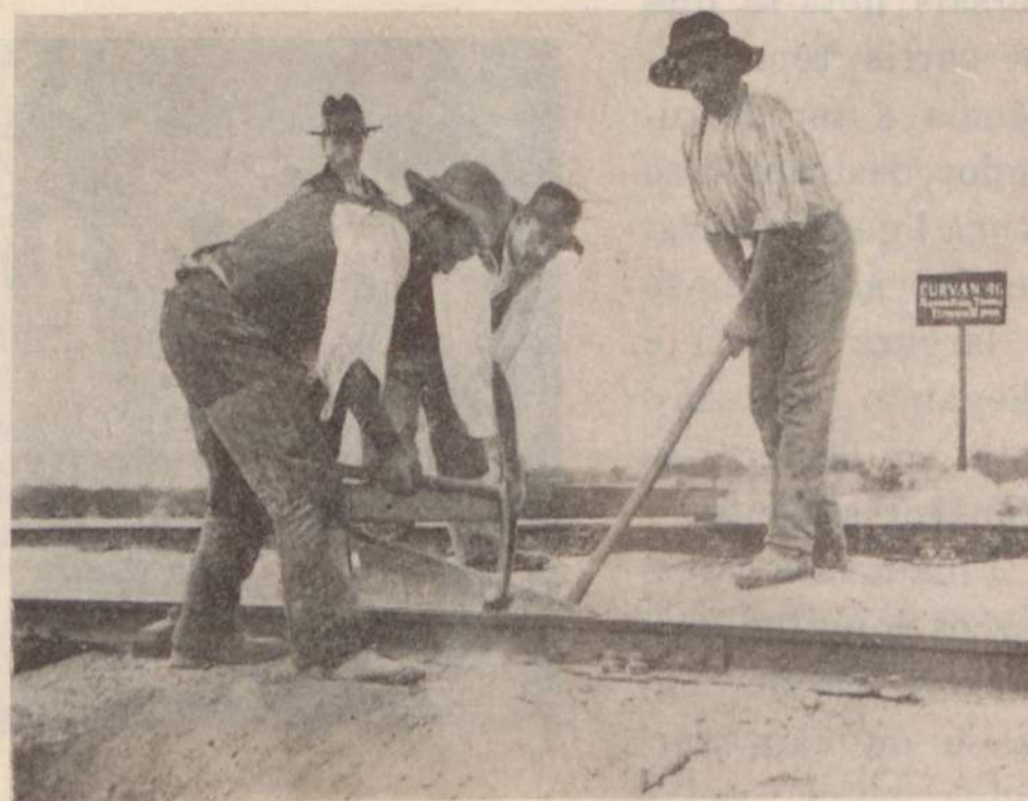
Nivelamento da via em curva
