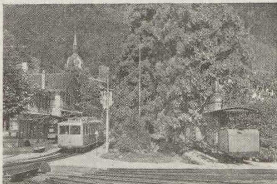
A estação inferior do Caminho de Ferro de gramalheira de Vitznau ao cume do Rigi. Esta linha, actualmente explorada com tracção eléctrica, é uma das mais antigas vias férreas de gramalheira do Mundo. À direita, vê-se uma das suas primeiras locomotivas de vapor, de cilindro vertical
