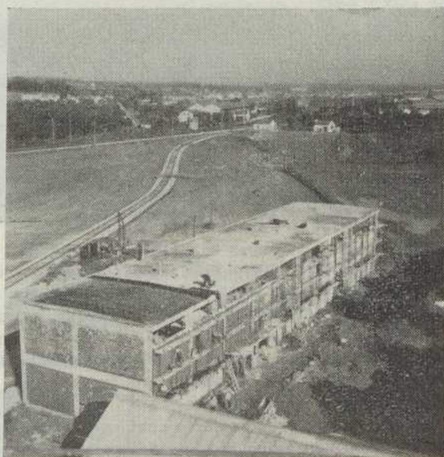
FIG. 2 — Instalações do pessoal do Posto de Manutenção — onde foi aplicado betão C 1
