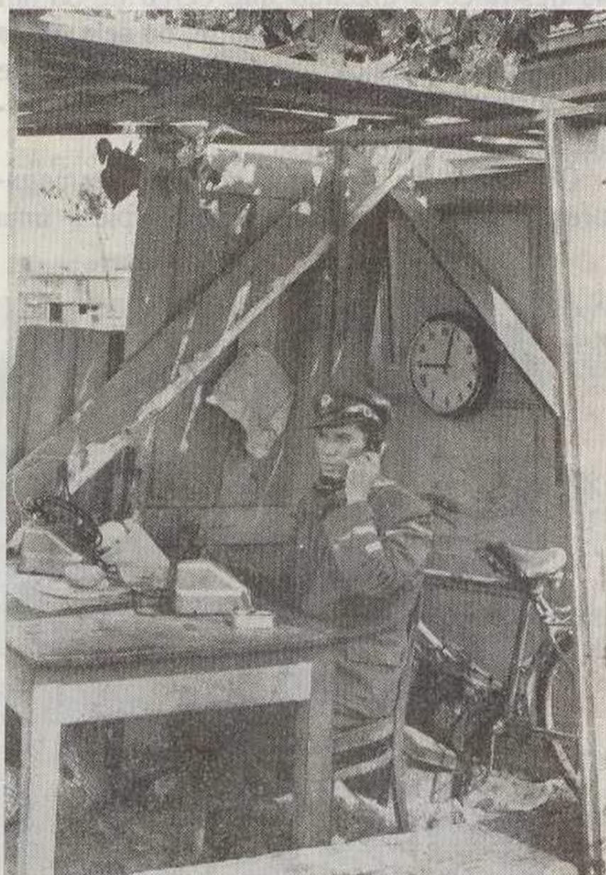
O serviço ferroviário recomeçou logo que possível. Este é o gabinete, improvisado, do chefe da estação, funcionando ao ar livre
