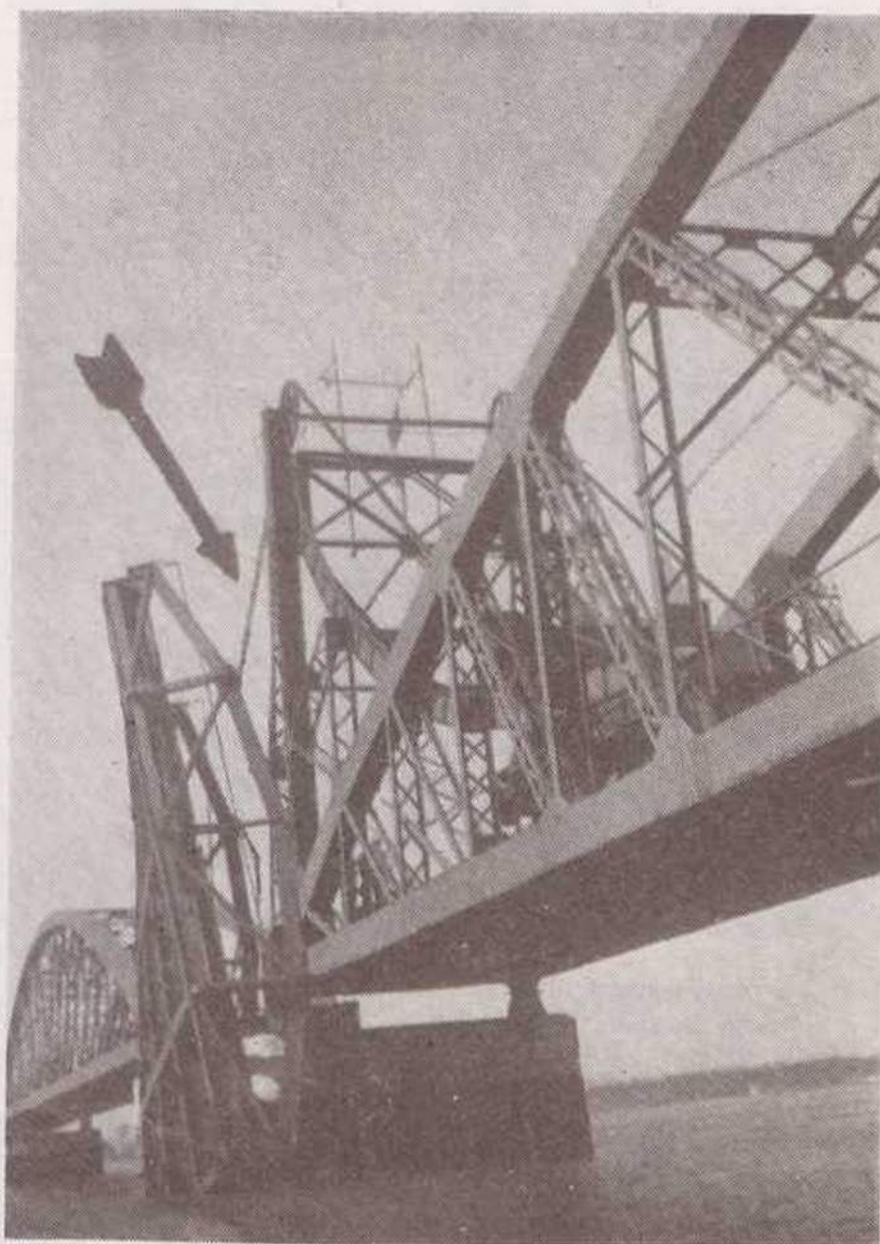
Posição em que ficou o tramo levadiço após o embate. Notar o empenamento do tabuleiro e a corrente Galle por que ficou suspenso
