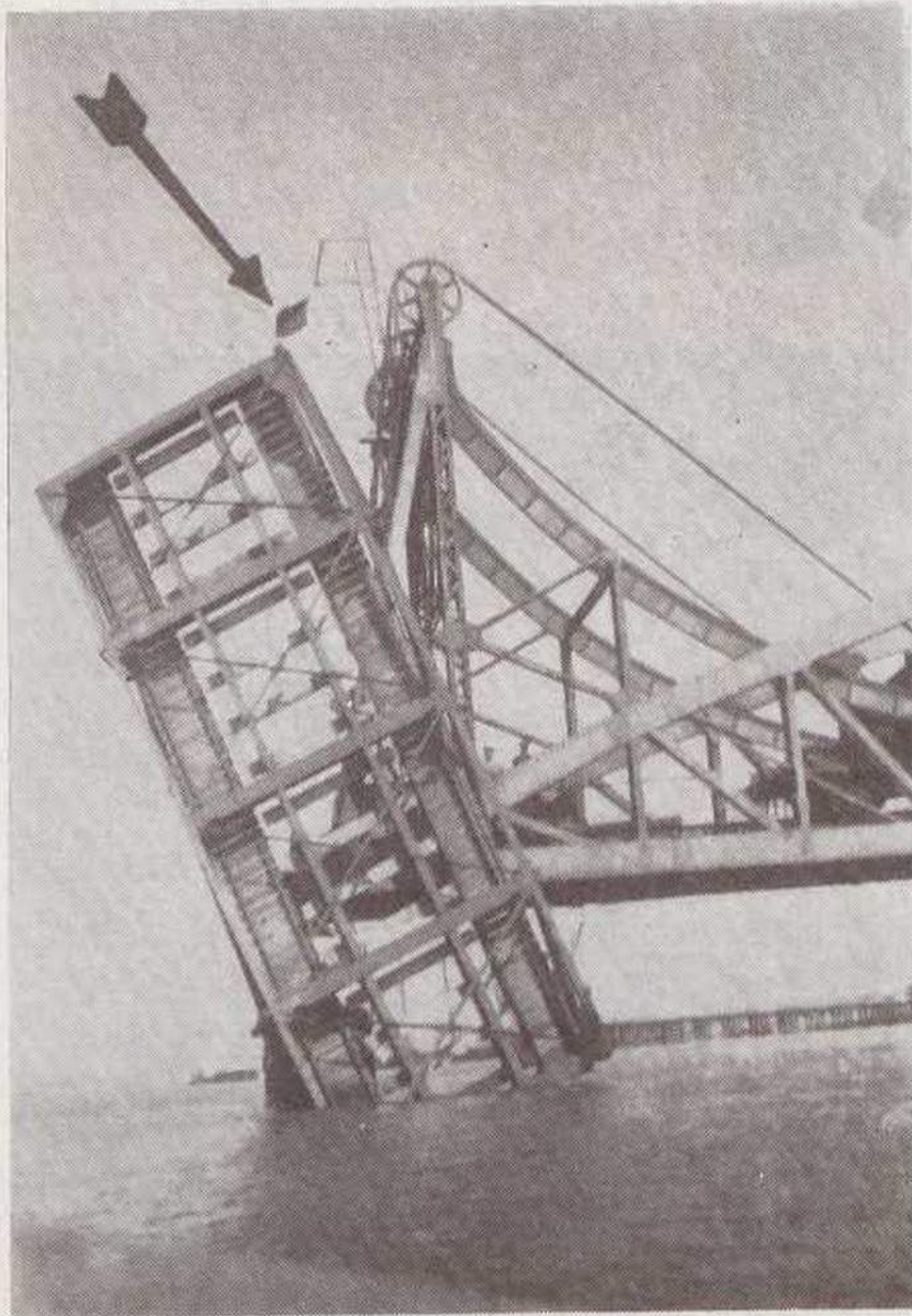
Outro aspecto da posição do tramo levadiço após o embate. Notar o sinal (bandeira) interditando a passagem dos barcos
