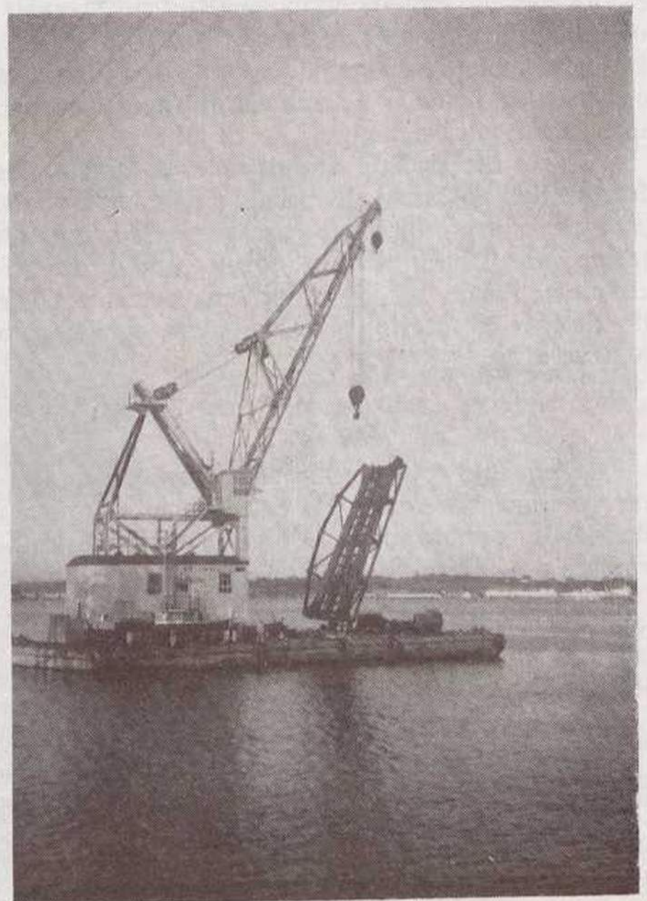
Transporte do tramo levadiço com a cábrea «Eng. Manuel Espregueira», da A. G. P. L.
