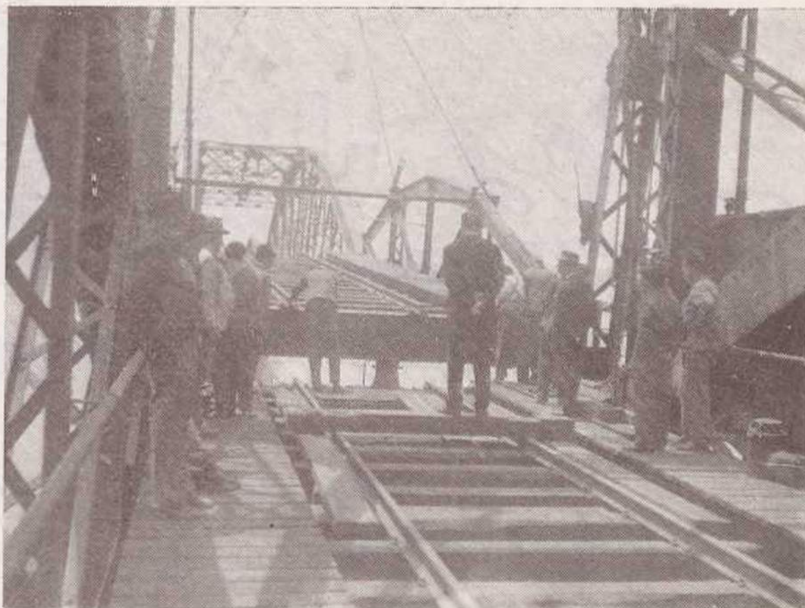
Montagem do tramo após a reparação
