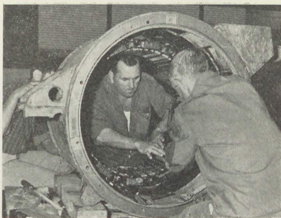
Trabalhos de bobinagem na oficina de grande reparação
