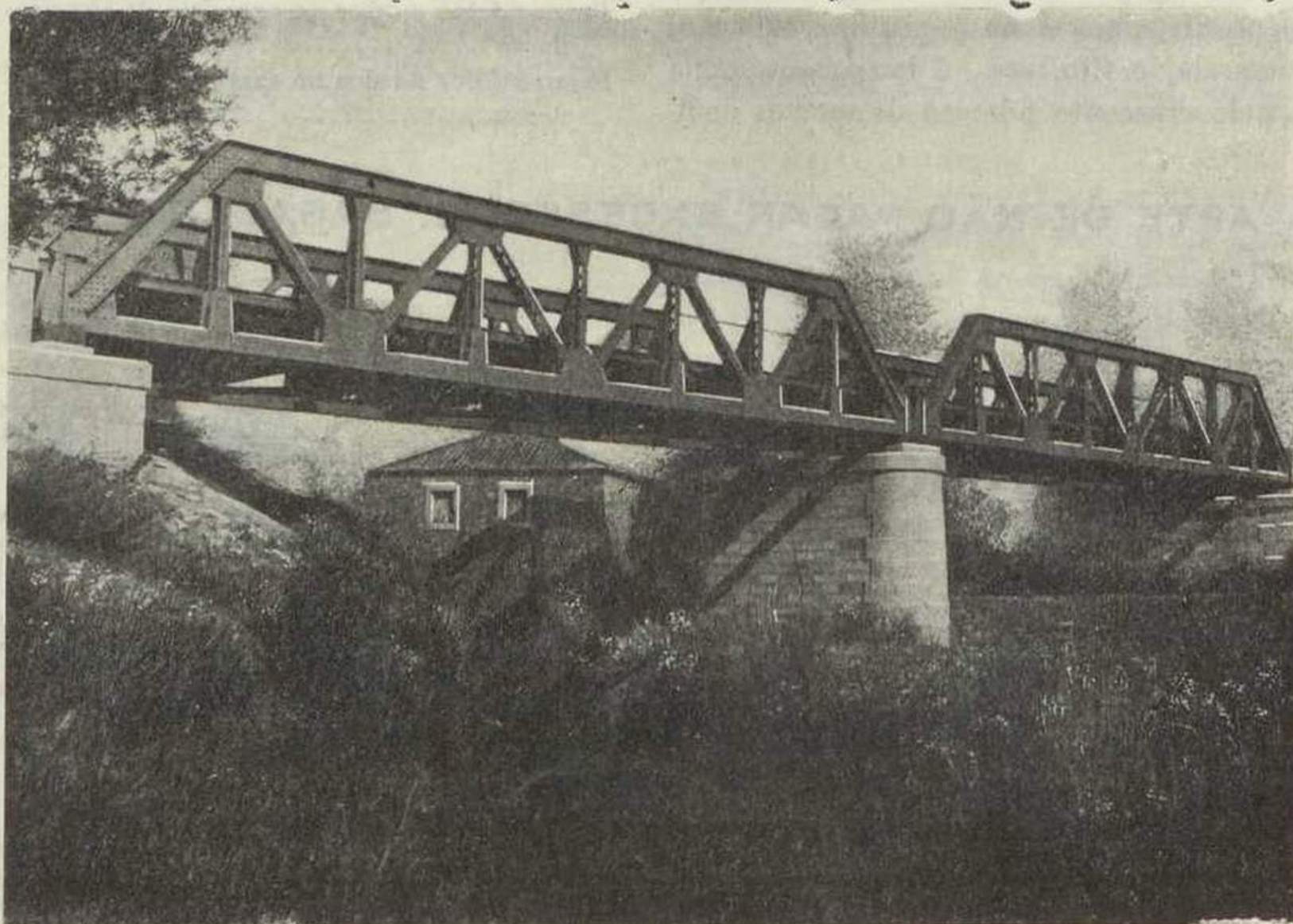
Ponte na linha de Oeste
