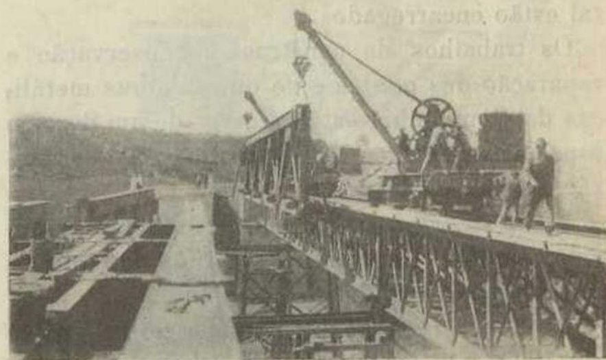
Fig. 2 — Montagem de uma viga de 21 metros por meio de guindastes na ponte da Ribeira de Vide (Ramal de Cáceres)
