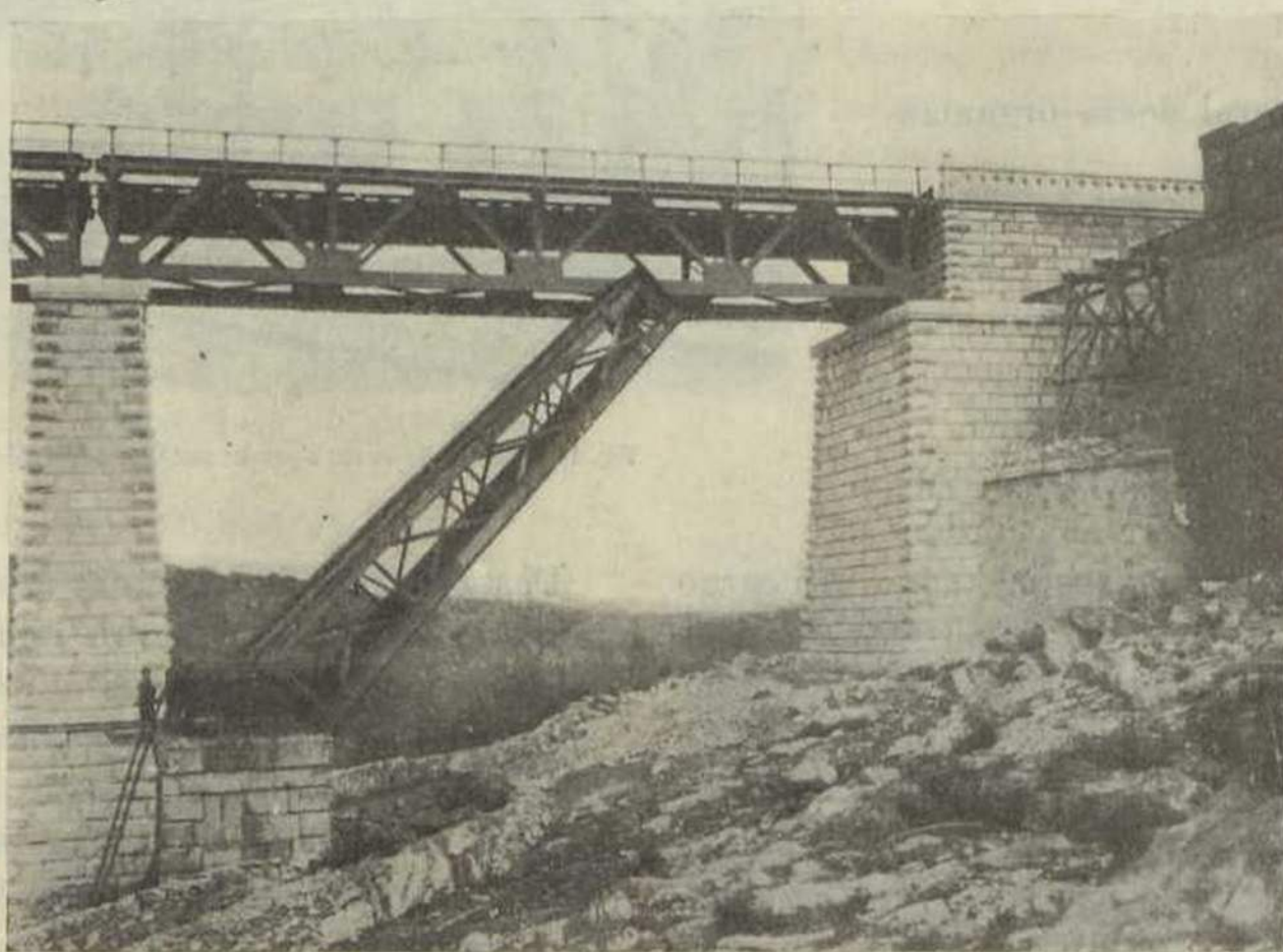
Fig. 6 — Derrubamento de um pilar na desmontagem da ponte velha da Ribeira de Vide (Ramal de Cáceres)
