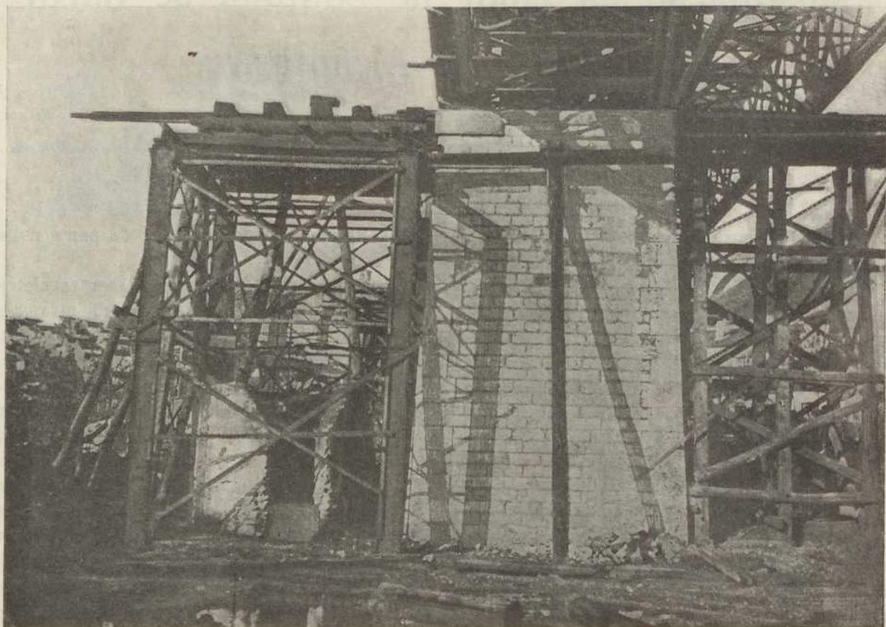
Fig. 1 — Fotografia mostrando os cavaletes de suporte, um dos quais circunda um poço que existe junto a um dos pilares de alvenaria, o que obrigou a disposições especiais
