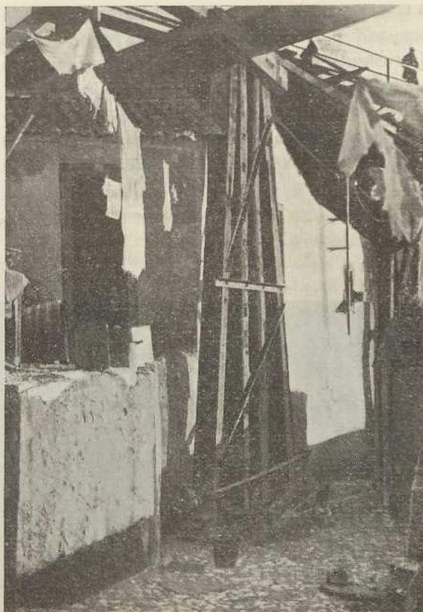
Fig. 3 — Tipo especial de um cavalete montado junto a um aglomerado de habitações
