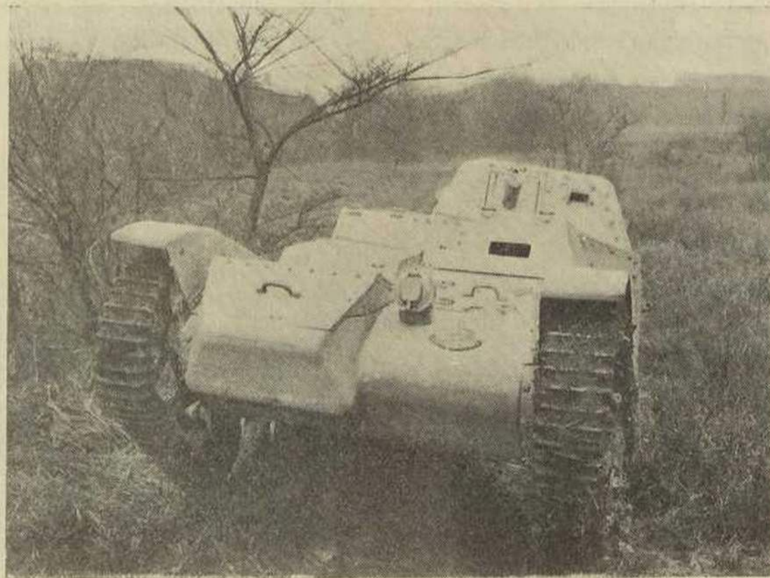
Um carro ligeiro de combate. Desloca-se com rapidez e facilidade em todos os terrenos. Tem um raio de acção de 170 Km.
