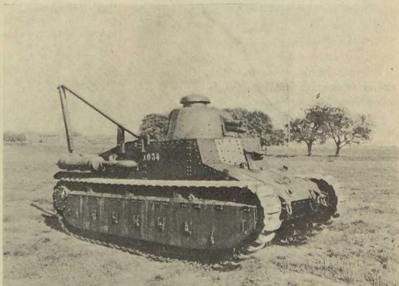
Outro aspecto de um carro de combate de fabricação francesa. Está munido de um aparelho receptor de telegrafia sem fios. Tem lugar para três homens de equipagem. Pesa 11 toneladas e tem de comprimento 5m,300
