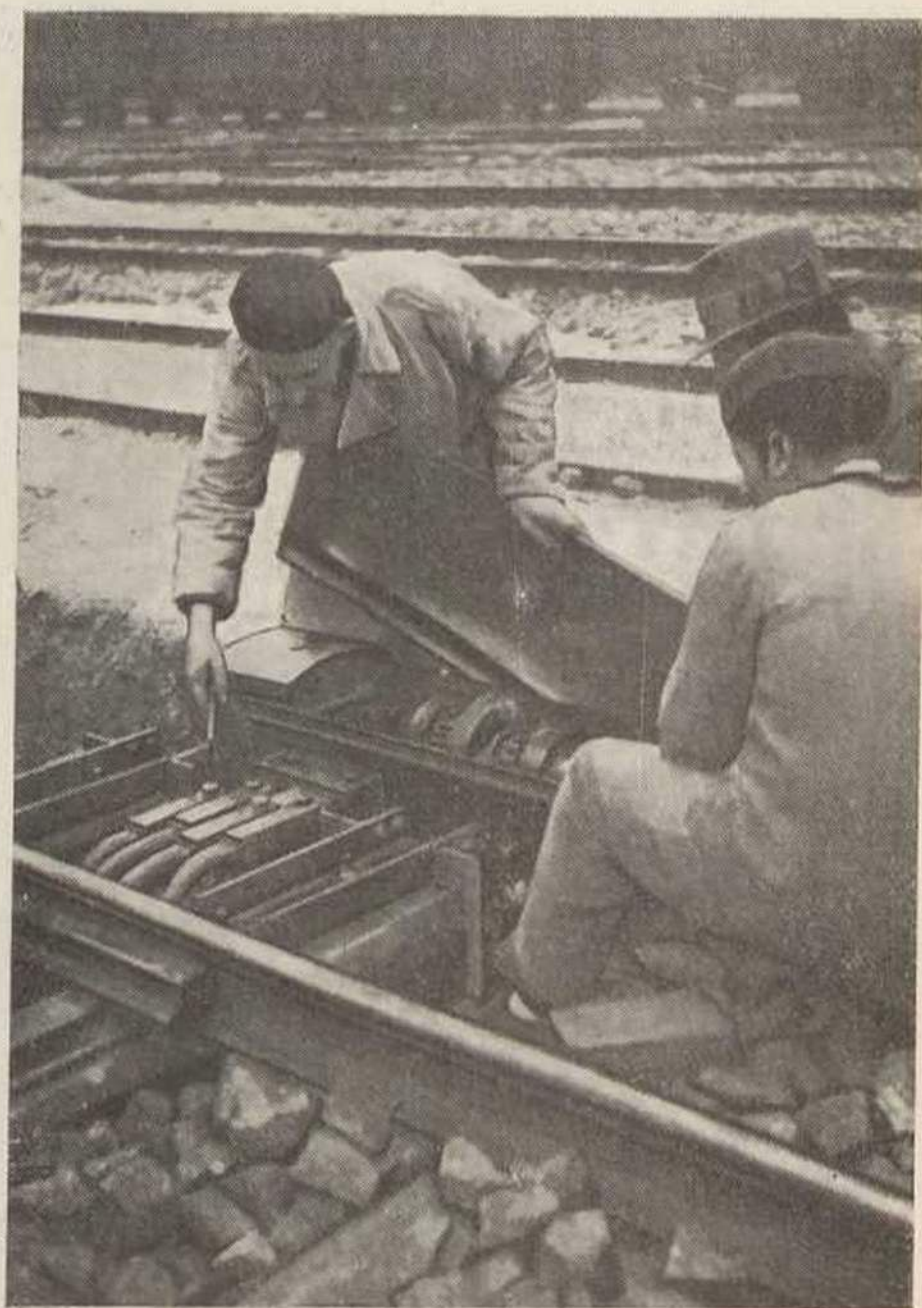
Fig. 12 — Regulação de um motor de agulhas
