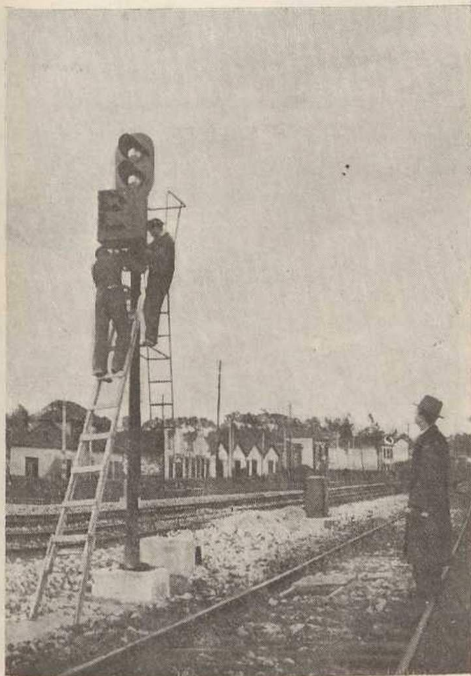
Fig. 8 — Montagem de um sinal de partida
