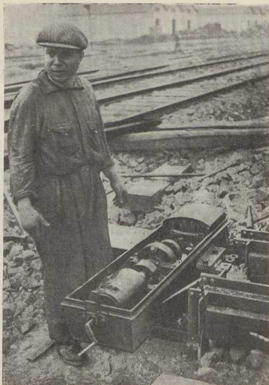
Fig. 11 — Montagem do motor de agulhas
