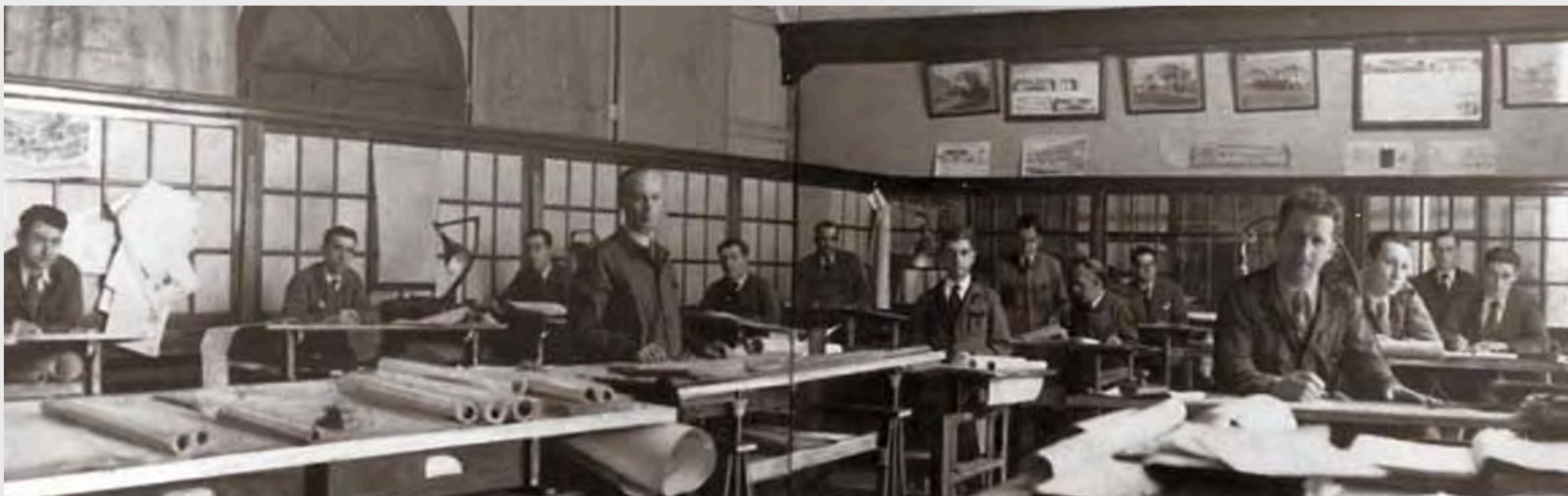
Sala de Desenho do Serviço de Via e Obras da CP - dezº 1958.
