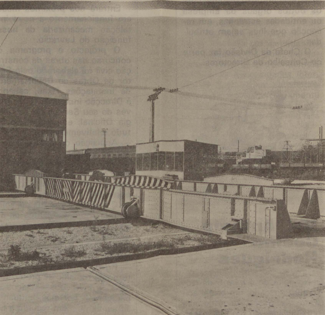
O transportador entre as duas oficinas
