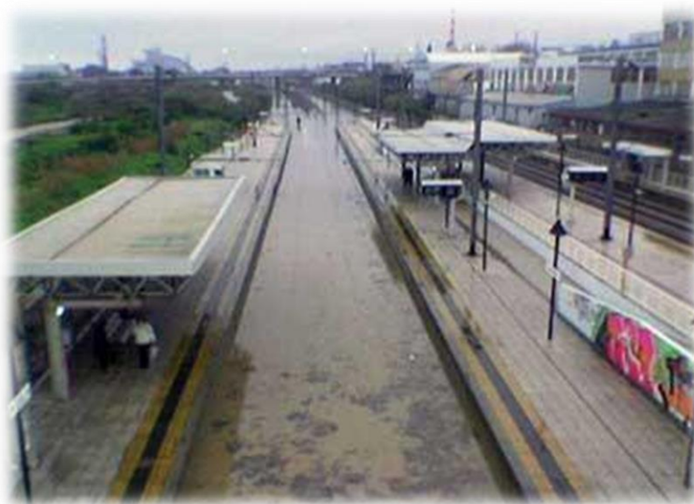
Figura 11 – Cheias na Linha do Norte, cobrindo completamente as vias de circulação, tendo a água subido praticamente à altura das plataformas.
